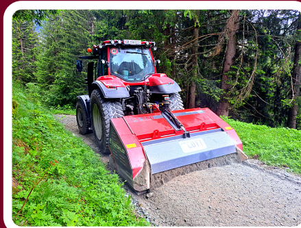
Fräsen mit mobilem Steinbrecher
