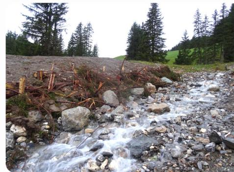
Verbauungen aus Rundholz sind eine landschaftlich gut angepasste und ökologische Variante um Erosions- und Rutschflächen zu stabilisieren. Wir führen Hang- und Bachverbauungen aus Holz und Stein durch und erstellen oder erneuern Drainagen und Sickerleitungen.
