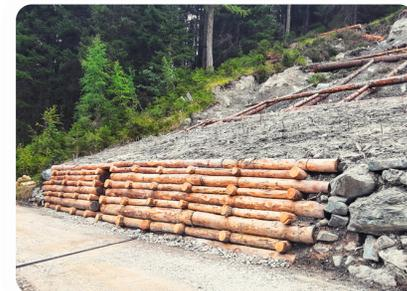
Verbauungen aus Rundholz sind eine landschaftlich gut angepasste und ökologische Variante um Erosions- und Rutschflächen zu stabilisieren. Wir führen Hang- und Bachverbauungen aus Holz und Stein durch und erstellen oder erneuern Drainagen und Sickerleitungen.
